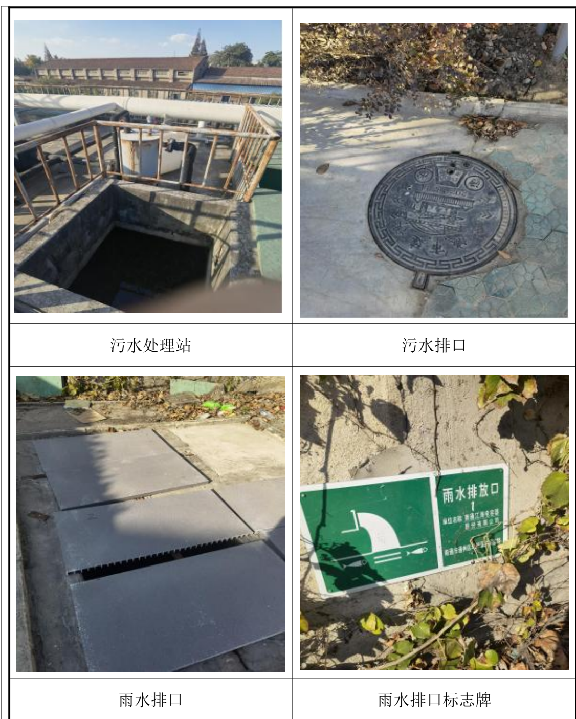
图 3-2 废水处理设施照片
