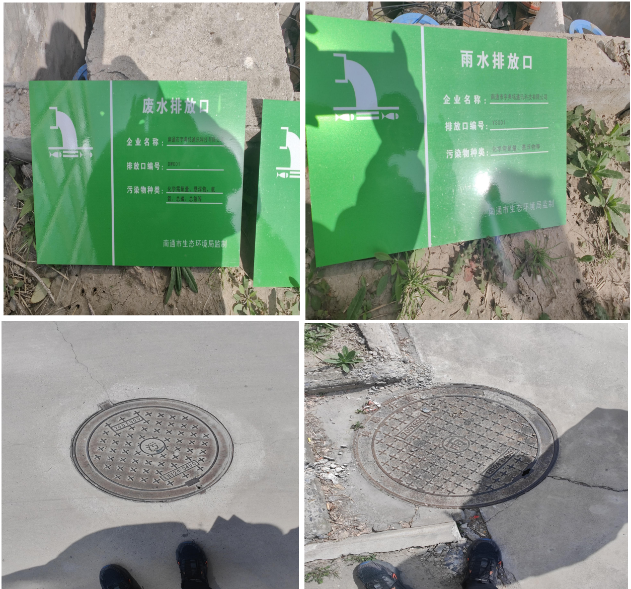
图 3-1 雨污水排口及标识标牌
